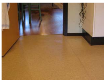
Bild 11. En mindre nivåskillnad (2 centimeter) kan jämnas ut med avfasning/uppspackling av golvet med flack lutning (max 1:50). En list ligger över skarven mellan golvmaterialet.
