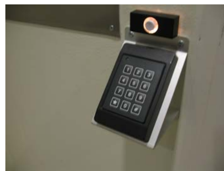
Bild 14. Automatisk dörröppning kan också ske via kortläsare, kodlås eller porttelefon. Kortläsaren där kortet inte behöver dras utan hålls framför och där kortläsaren är utvinklad kan placeras i intervallet 0,8 – 1 meter över golvet. Utvinklingen gör att man lättare kan se text/symboler och avläsa taktila markeringar.
