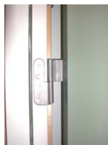
Bild 3. Med hjälp av särskilt utformade gångjärn förskjuts dörrbladet så att det inte inkräktar på det fria passagemåttet när dörren är öppnad 90 grader.
