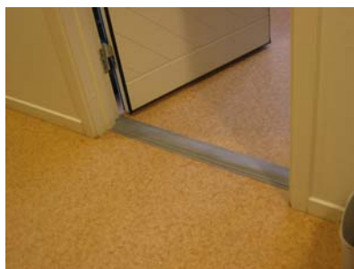
Bild 9. Exempel på mjuk luftfylld gummitröskel.
